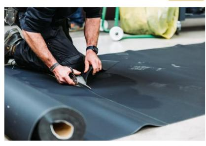
Het APOROOF EPDM membraan van 1,5mm dik is uitermate geschikt als dakafdichting en heel eenvoudig te plaatsen zonder veel toebehoren te moeten gebruiken.
